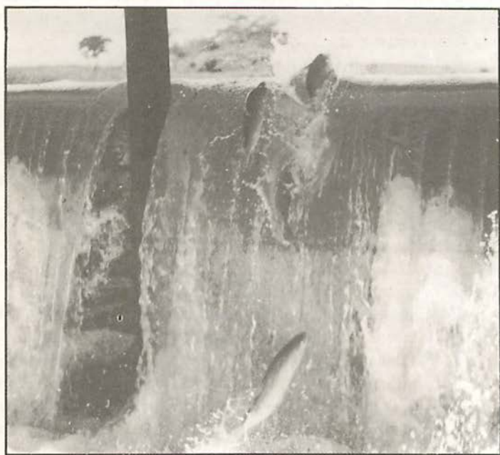
Fig. 3 – Cachoeira de Emas, Rio Mogi Guassu. Escada de peixes, vista parcial do último degrau-tanque, tirada em 26.10.1959, durante a migração reprodutiva de peixes de piracema.
