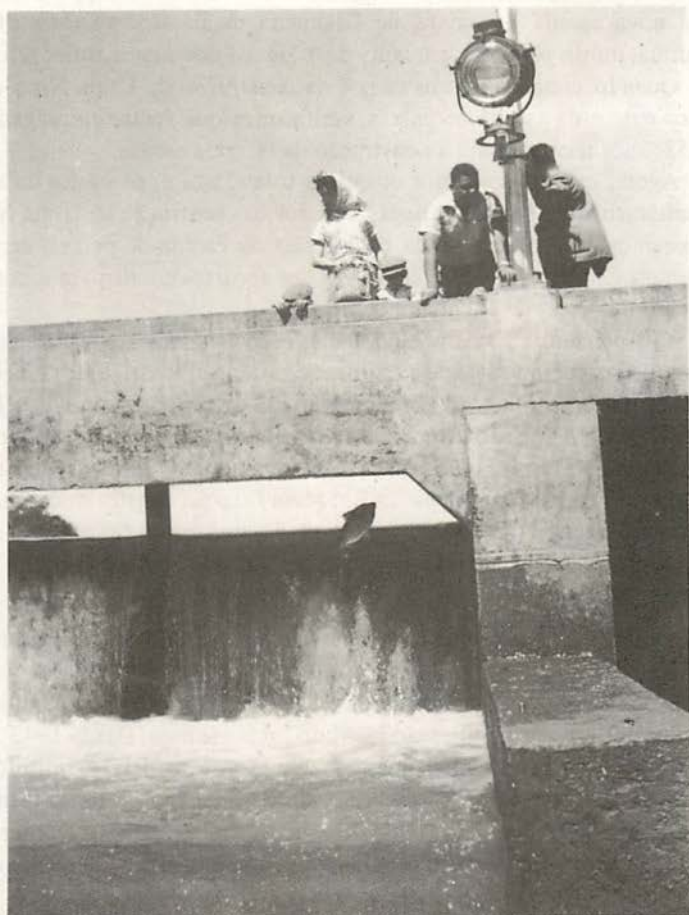
Fig. 4 – Mesmo local da foto anterior, mostrando um curimatá ( Prochilodus scrofa ) num salto de um pouco mais de 2,0m de altura para vencer a diferença de 1,80m de altura do último obstáculo, para ganhar o rio novamente, a montante da barragem. Velocidade do rio, na passagem do último obstáculo, com cerca de 2,60m/s ( \approx 9,36 km/h). Barragem original construída com 3,0m de altura entre 1920 e 1922. Depois, elevada para 5,0m entre 1942 e 1949. Foto em 26.10.1959.
