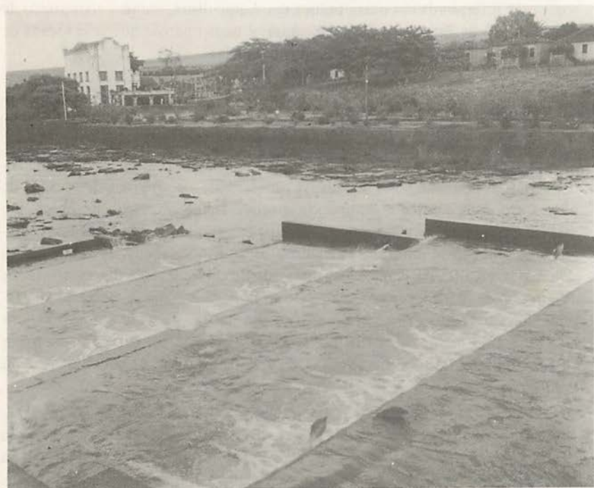
Fig. 2 – Cachoeira de Emas, Rio Mogi Guassu. Escada de peixes, vista parcial, tirada em 26.11.1954, durante a migração reprodutiva de peixes de piracema. Na foto podem ser vistos alguns peixes (curimatá, Prochilodus scrofa e pia-va, Leporinus copelandii ) saltando através dos degraus-tanques da escada. O edifício maior, no fundo, é o do local da chamada Usina Nova de Emas, construída entre 1940 e 1945. (Atualmente, pertence à CESP-Companhia Energética de São Paulo e está em operação, após as reformas concluídas em 1985).
