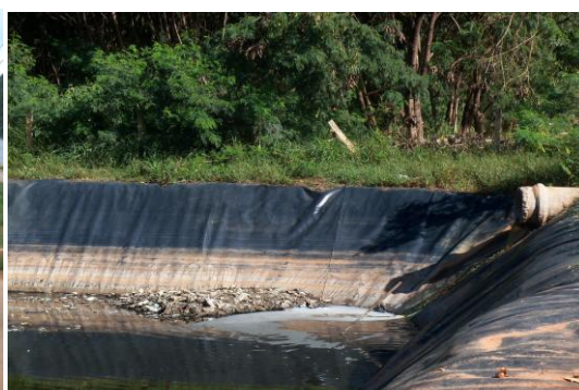
Figura2. Lagoa de chorume, no “Lixão do aterro do Jockey”, na cidade Estrutural, DF.
