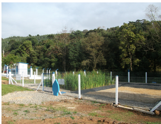
Figura 1 Sistema de zonas de raízes concluído.
