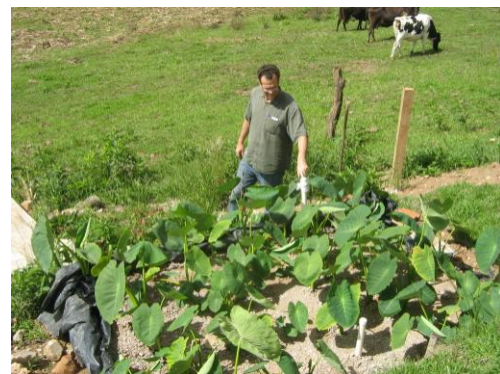
Figura 5 – Estação de tratamento de esgoto por raízes, construída pela EMATER.
