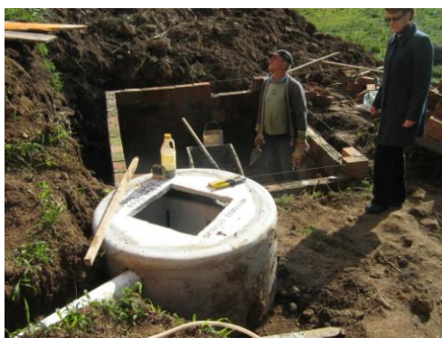
Figura 4 – Estação de tratamento de esgoto por raízes, em construção.
