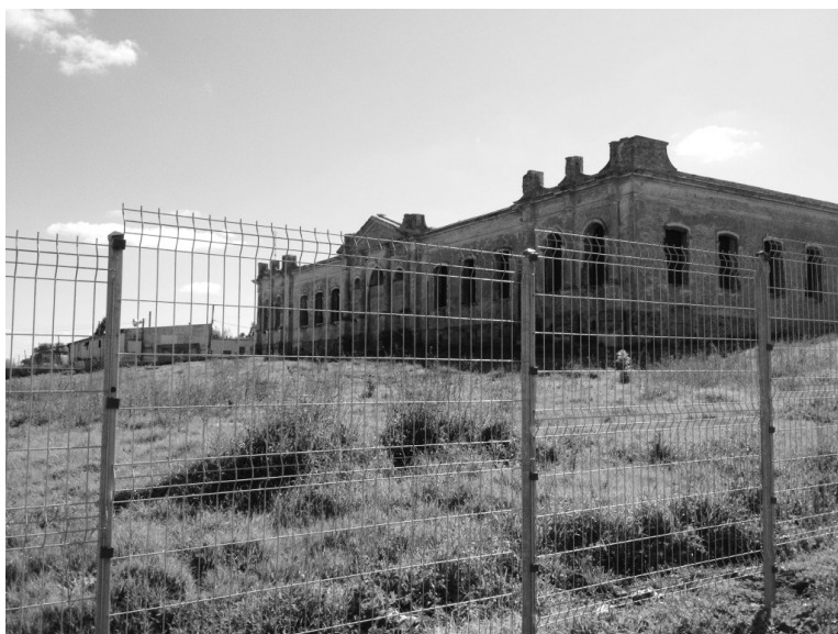
Figura 7. Cerca no entorno da obra do CIP
