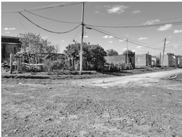
Figura 6. Entorno da obra do CIP. Vila do Cerro da Pólvora
